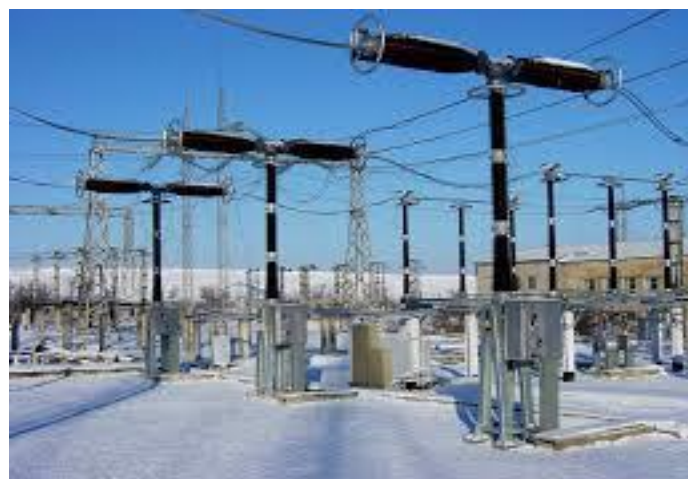
Figure. 5. Disjoncteurs à air comprimé
