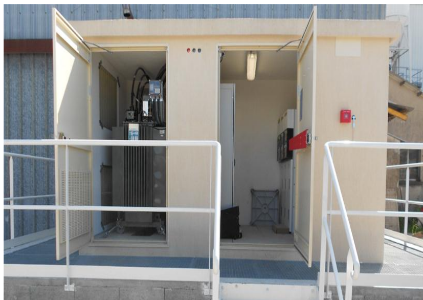
Figure 10. Structure d'un poste d'intérieur.
