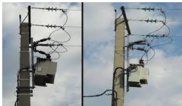
Figure 9. Structure d'installation d'un poste sur poteau
