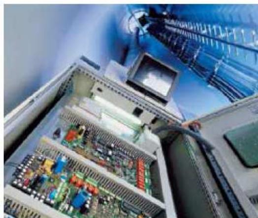
Figure 25. Contrôleur Enercon en pied de mât
